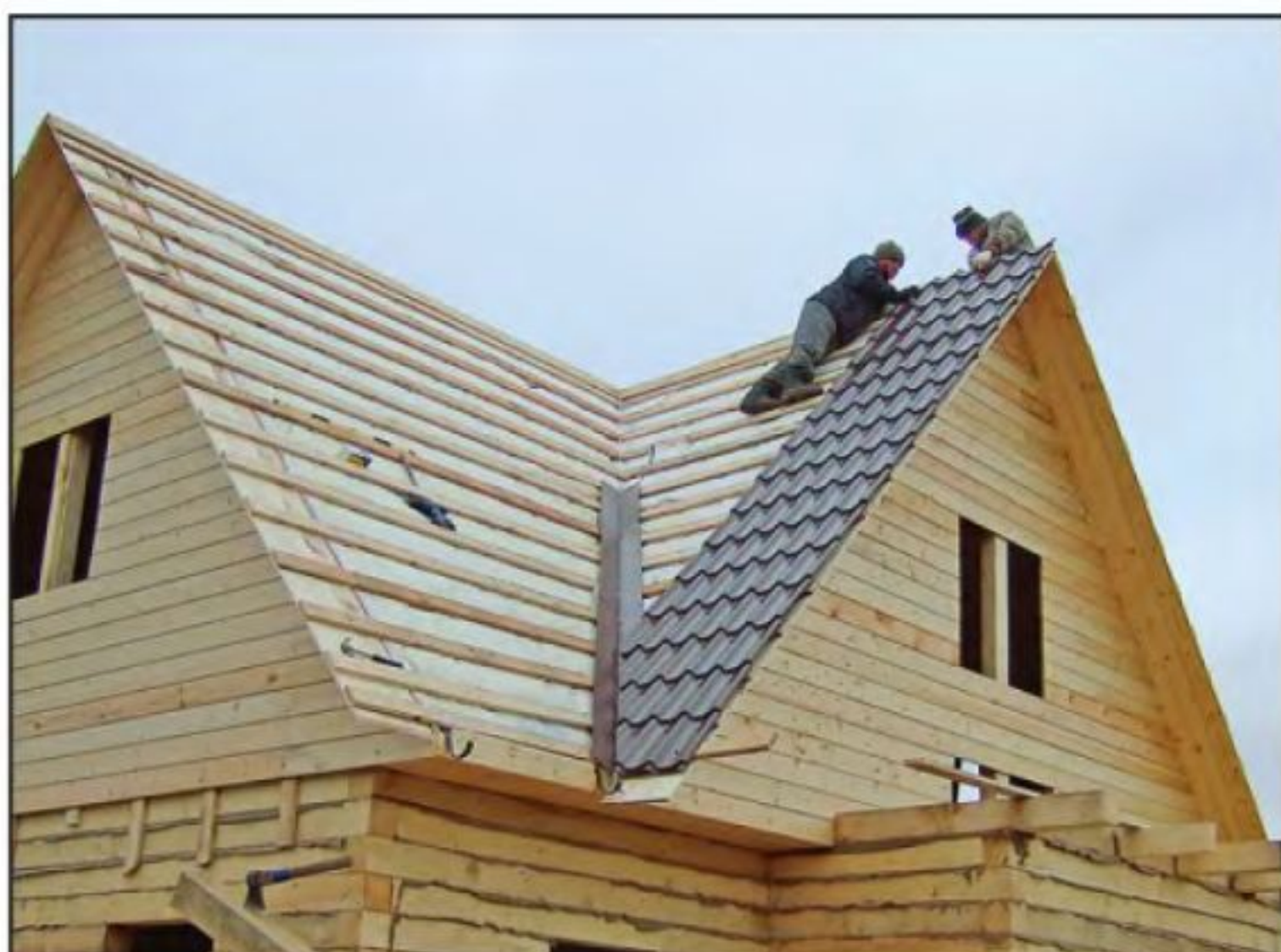
Последовательно, лист за листом, ведут укладку металлочерепицы.
