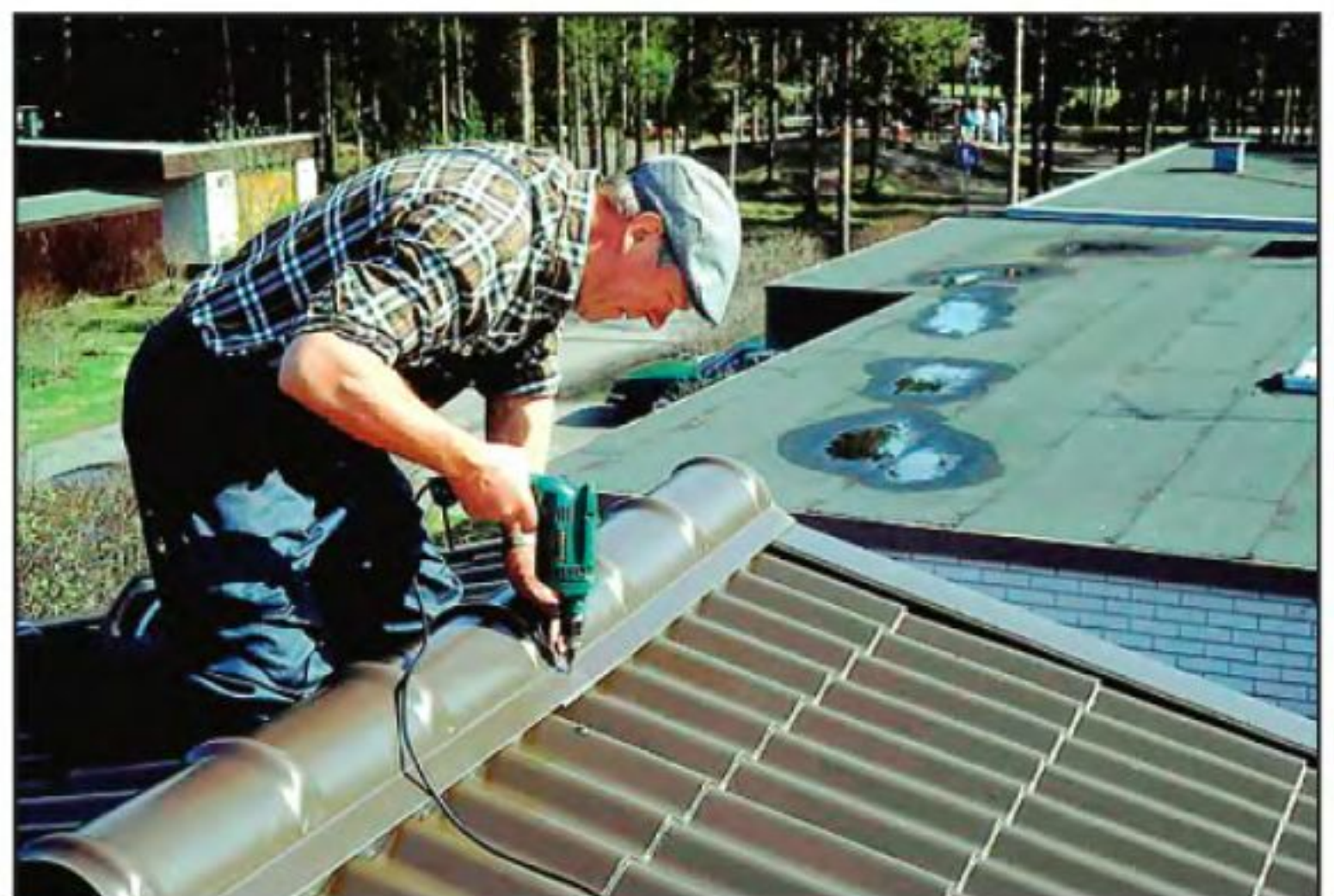
Каждую следующую коньковую планку ставят внахлёст на предыдущую и крепят к листам металлочерепицы саморезами.
