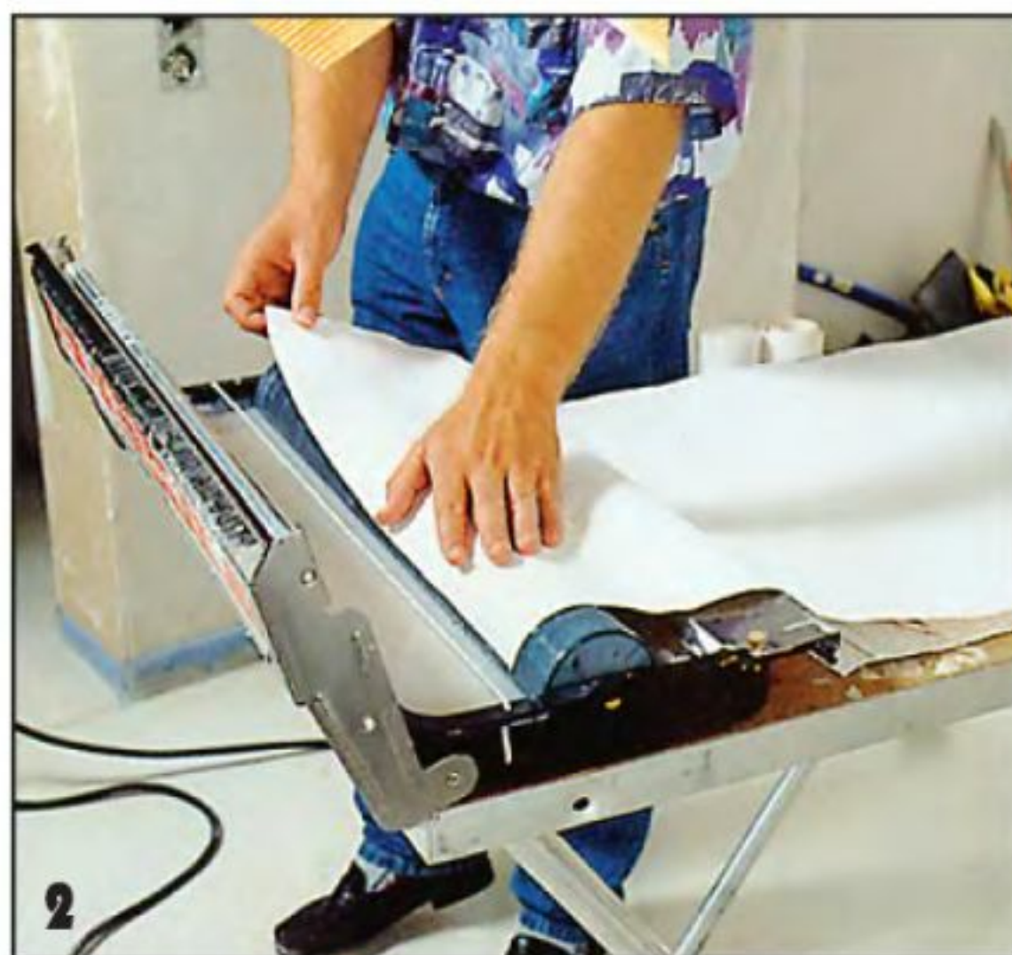
2 Заправляют полотнище в устройство для нанесения клея. Если такого устройства в домашней мастерской нет, можно обойтись малярным валиком и одежной щёткой.
