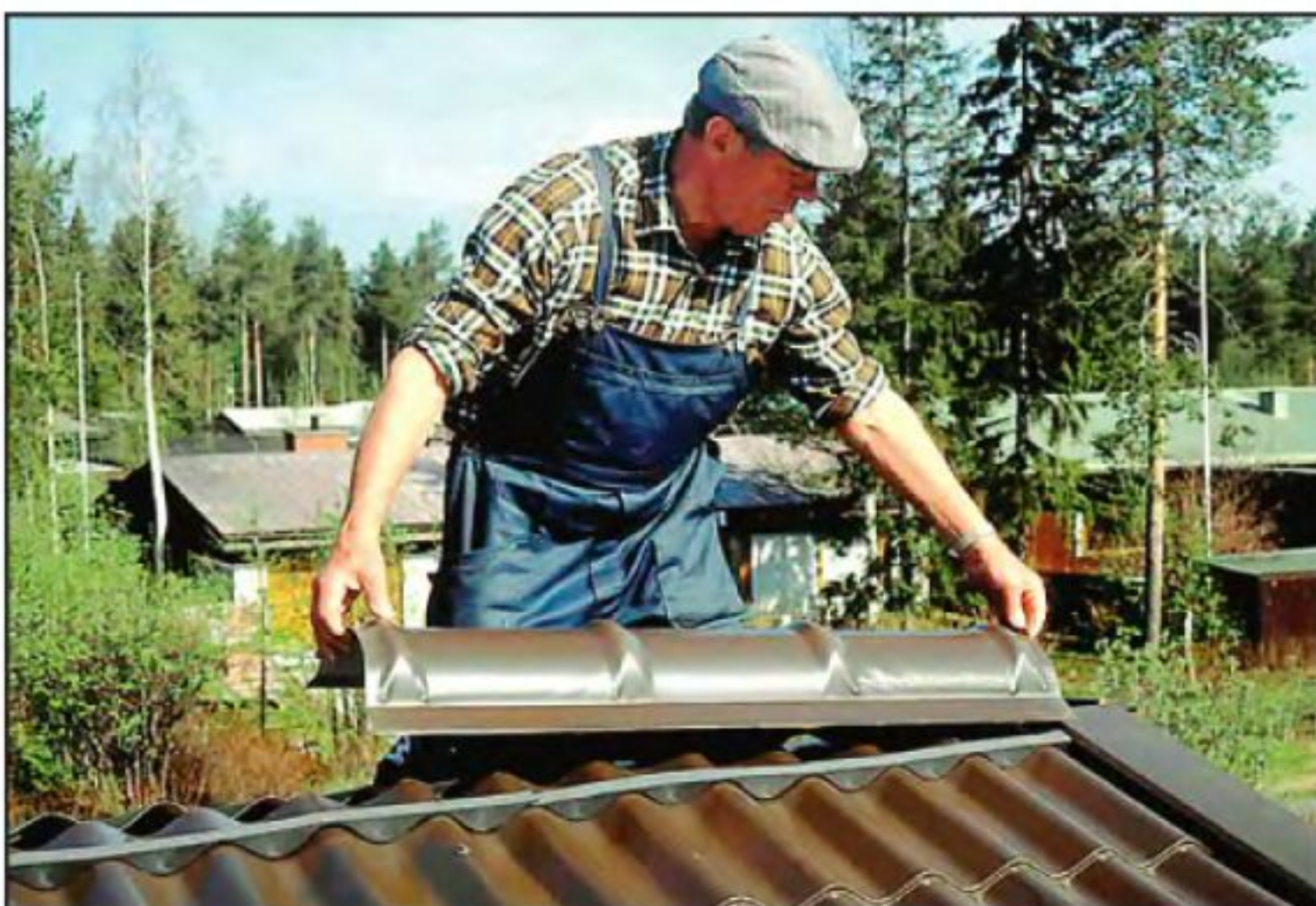
Разложив вдоль конька уплотнительные подкладки, устанавливают на них коньковые планки.
