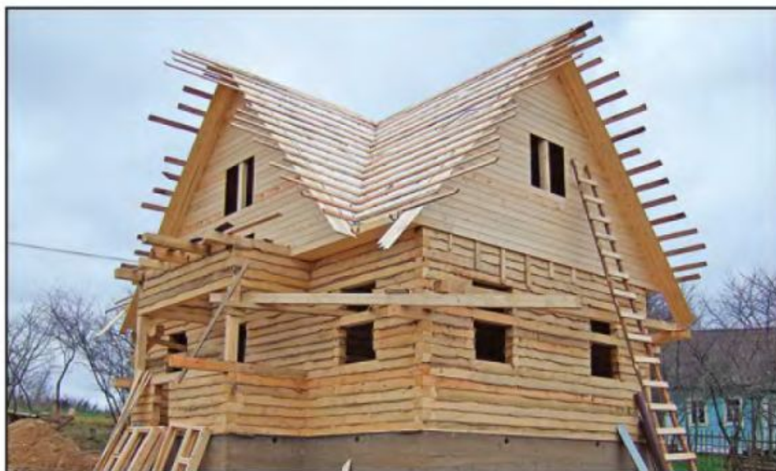
Поверх гидроизоляционной плёнки набивают обрешётку с соответствующим металлочерепице шагом.
