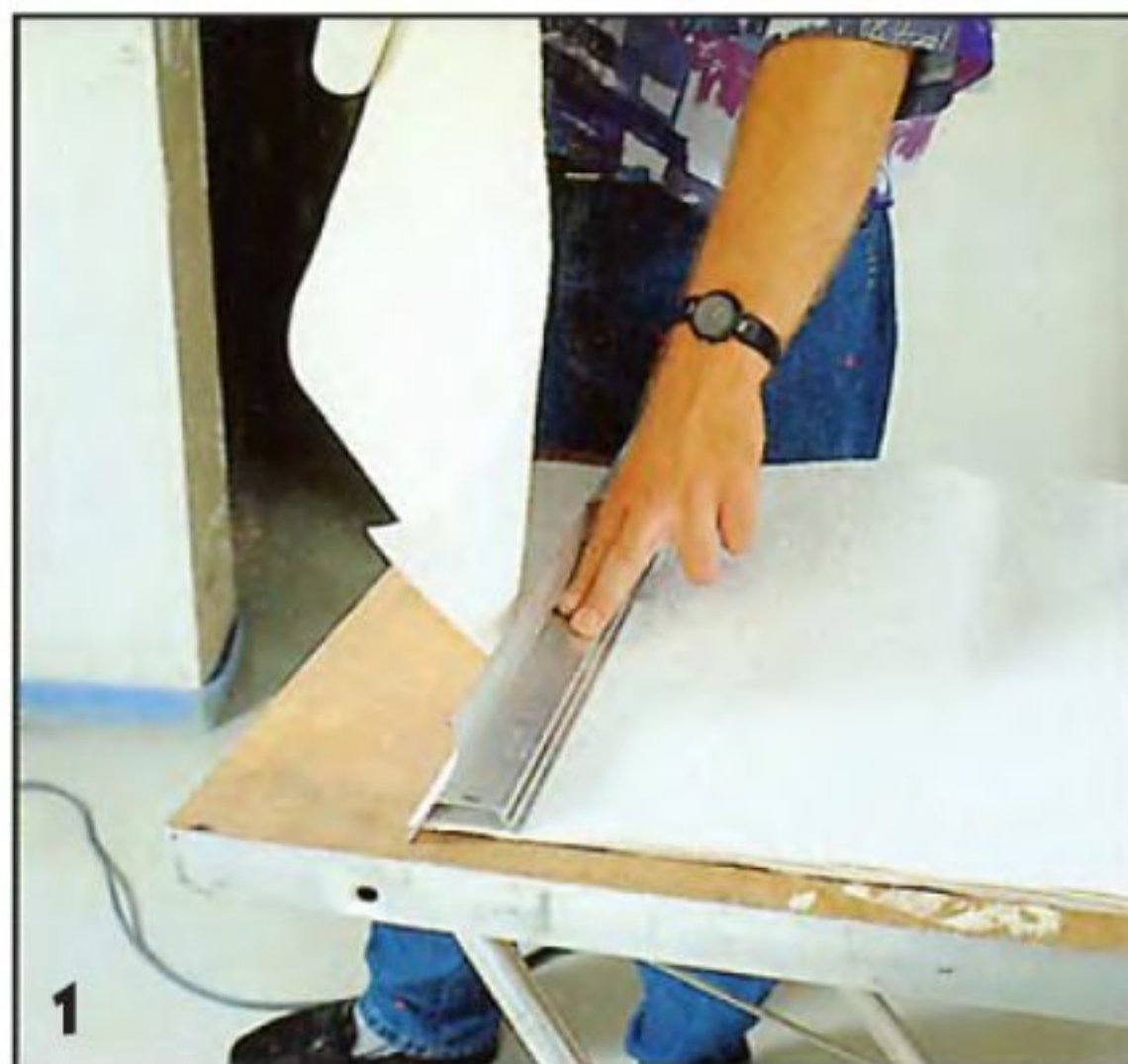
1 Сначала оклеивают обоями потолок. Полотнища раскраивают по длине с некоторым припуском.
