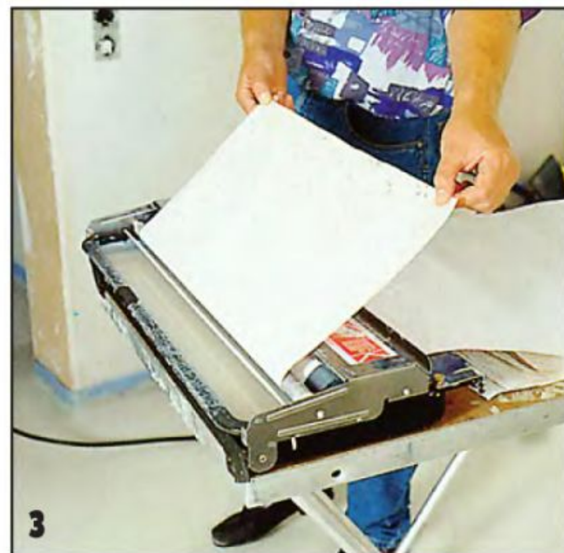
3 При протаскивании полотнища по валикам устройства клей равномерно распределяется по тыльной поверхности обоев.
