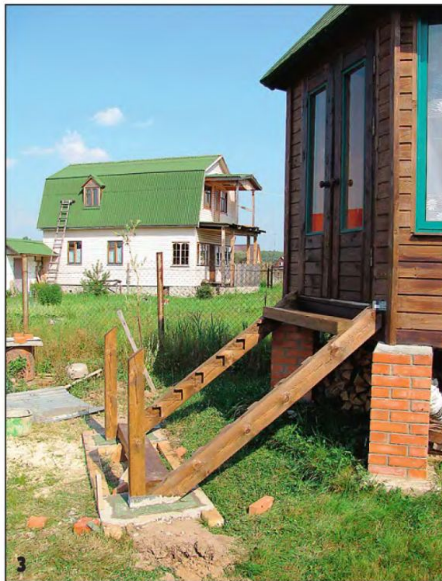
Предварительно установив тетивы и упорные балясины, можно приступать к заливке фундамента.
