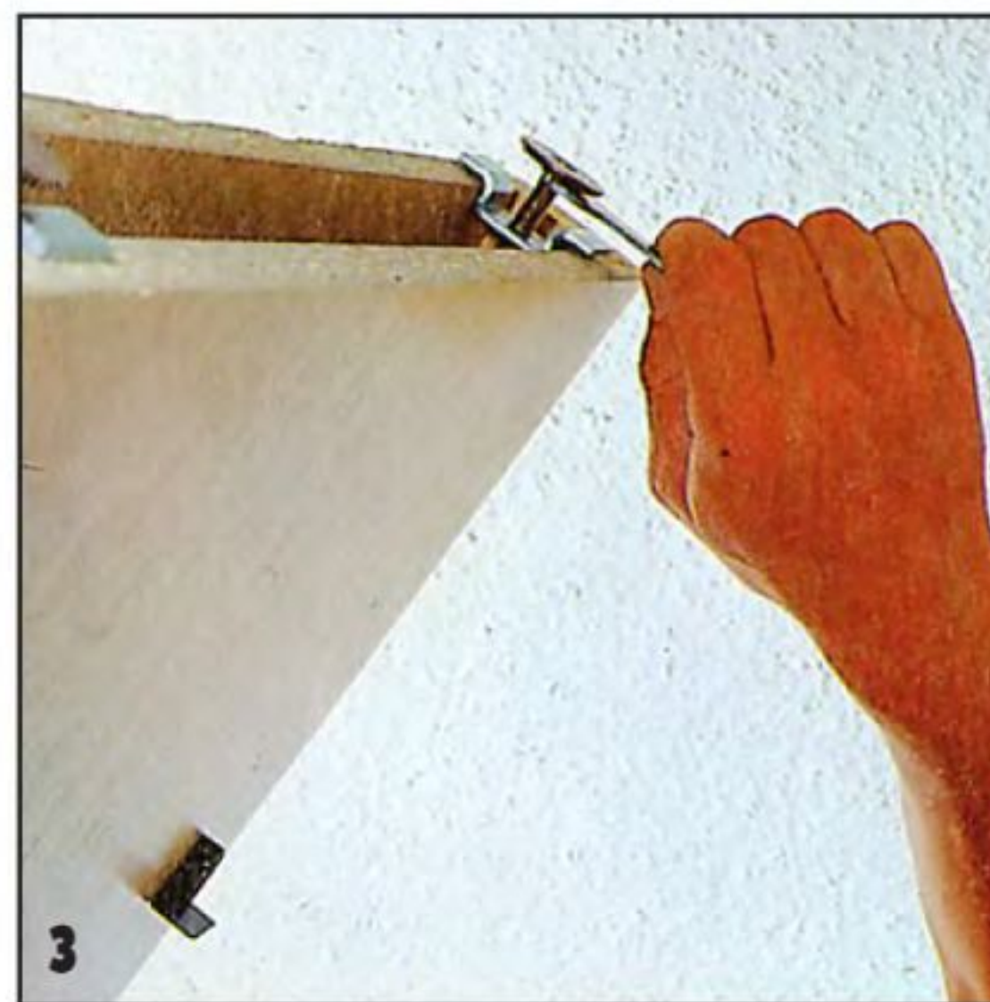
Для крепления стоек используют регулируемые резьбовые упоры (их высота — примерно 30 мм).
