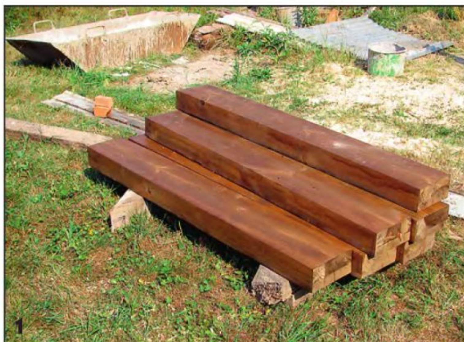
Готовые ступени из бруса сечением 100x200 мм — струганные, шлифованные и окрашенные.
