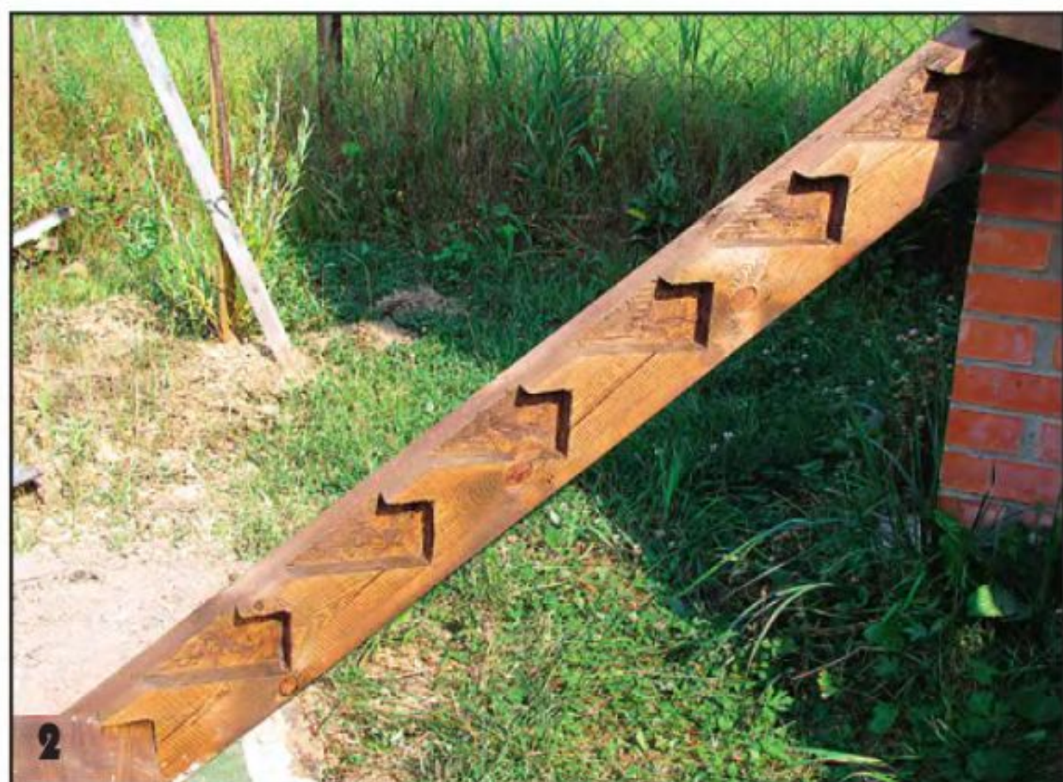
Тетива — тоже из бруса, но сечением 100x150 мм. Пазы под ступени уже выбраны.
