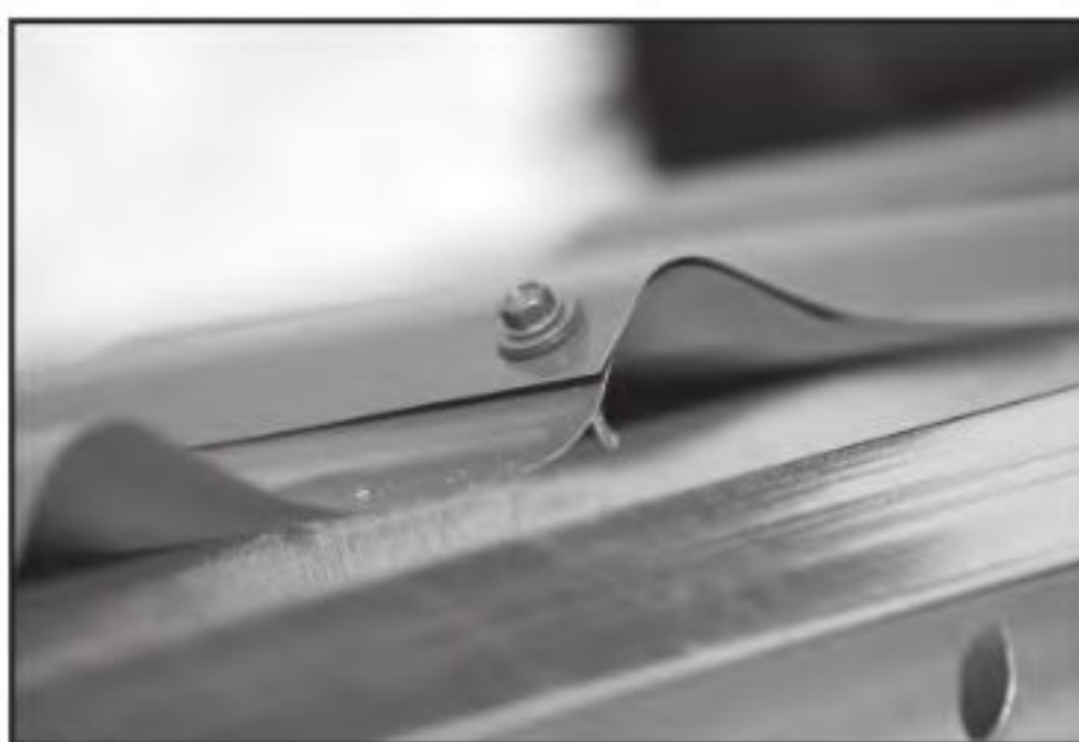
Рис.6. Листы металлочерепицы соединяют друг с другом саморезами по верхней кромке волны.
