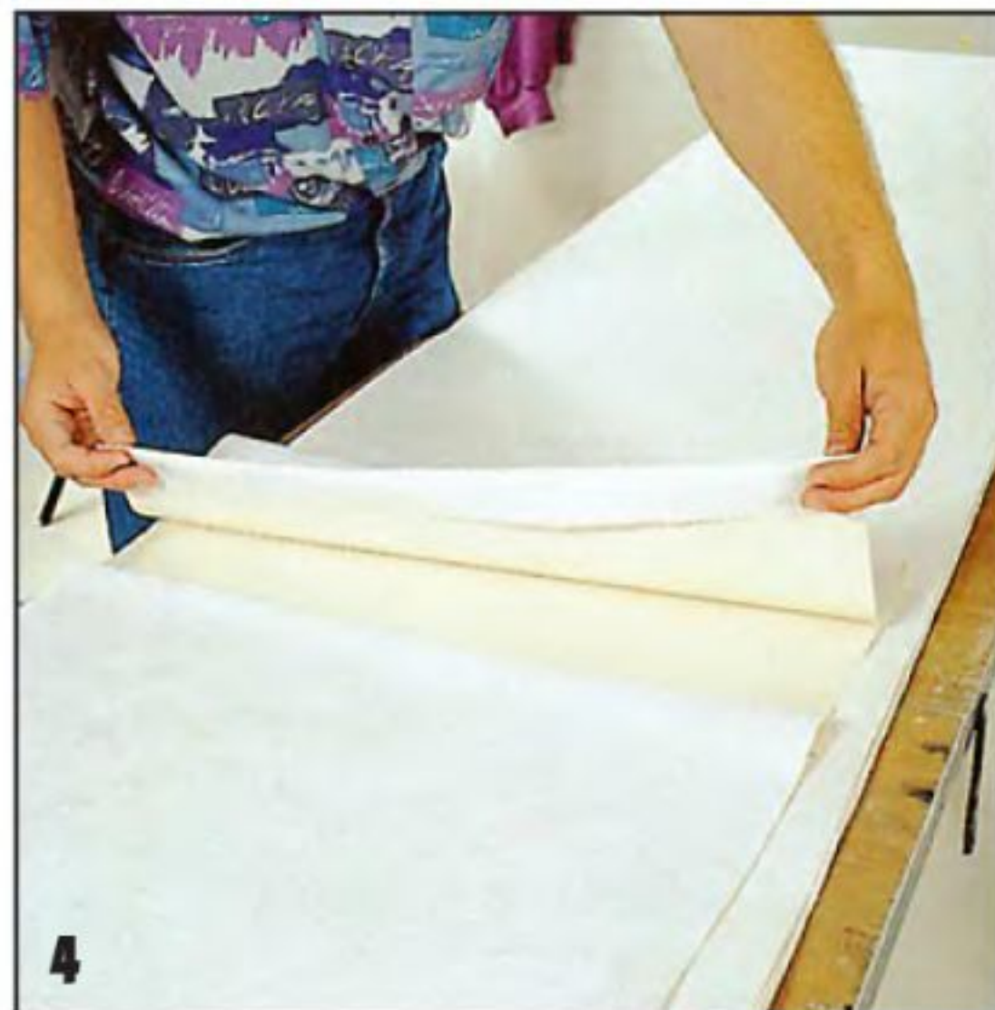
4 Полотнища складывают, совместив заподлицо его боковые кромки. Если концы полотнища завернуть на ширину 4 см, их потом легче будет отделить. Выдерживают промазанные клеем полотнища в сложенном виде.
